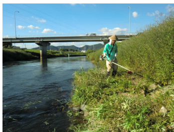
古川橋での草刈り作業の様子
